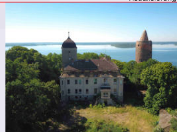
Noch ist das Schloss unsaniert.
